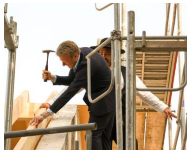
Carsten Preuß, Geschäftsführer der Philippusstift GmbH, bewies beim Richtfest handwerkliches Geschick, als es gemeinsam mit Zimmerermeister Marvin Kirchner nach dem obligatorischen Richtspruch darum ging, den symbolischen Nagel in den Dachbalken zu schlagen.
