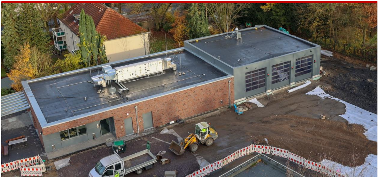
Die neue Feuerwache ist nach dem neuesten baulichen Standard konzipiert und bietet den derzeit 46 Mitgliedern ausreichend Raum für ihren Dienst bei der Freiwilligen Feuerwehr. Neben einem Sozialtrakt, Werkstätten, Lagerflächen und Umkleiden besteht der Baukörper aus einer Fahrzeughalle und einer neu sanierten Übungsfläche. Für die administrativen Aufgaben stehen mehrere Büroarbeitsplätze zur Verfügung.
