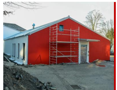
Der Baufortschritt der Rettungswache in Altenessen zum Ende des Jahres 2024. Diverse Kontrollen und Abnahmen stehen noch aus, dann wurde die Rettungswache im Frühjahr 2025 in Dienst gestellt.
